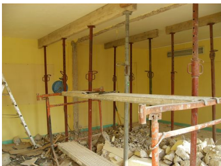
Démolition du pan de mur
