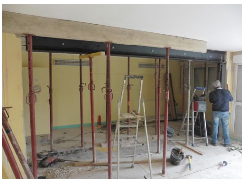
Pose de la poutre
